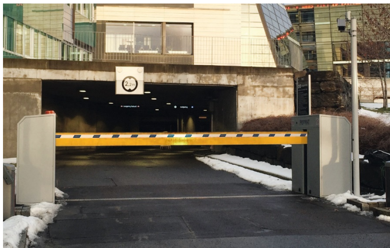
Figura 5: Barriere a movimento verticale per passaggi larghi fino a dieci metri sono parte della High Security Line. Consentono un ingresso e un'uscita controllate dei veicoli e sono adatte a elevate frequenze d'uso.
